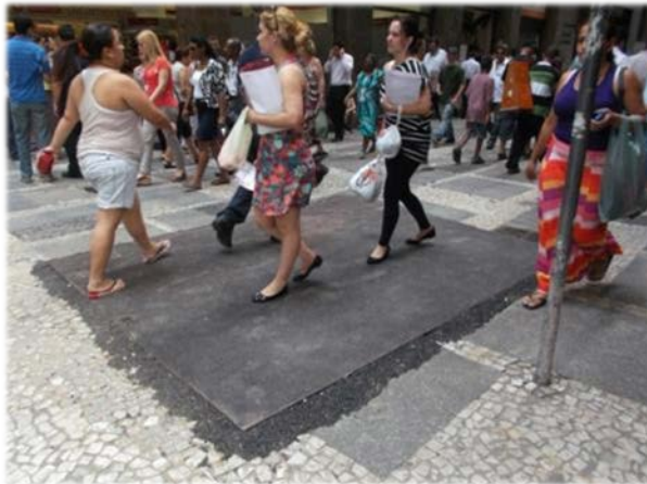
Figura 66 - Vista do piso de mosaico português e granito da Rua São Bento – manutenção nem sempre consegue manter o padrão do piso. Fonte Acervo pessoal, 2012.
