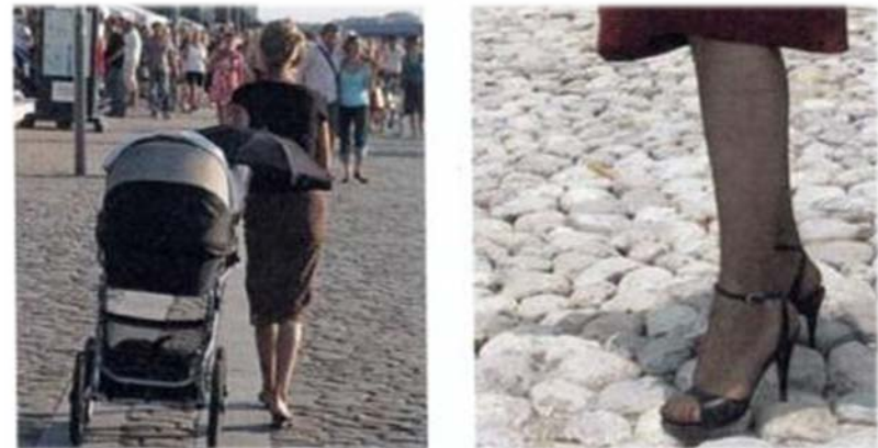
Figura 22 - Exemplos de matérias construtivas inadequadas nas calçadas com alta circulação de pessoas. Fonte: Gehl, 2010, p. 132.
