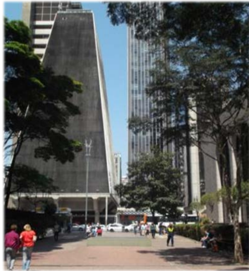
Figura 98 – Vista do prédio da FIESP pela Alameda Rio Claro. Fonte: Acervo pessoal, 2012.
