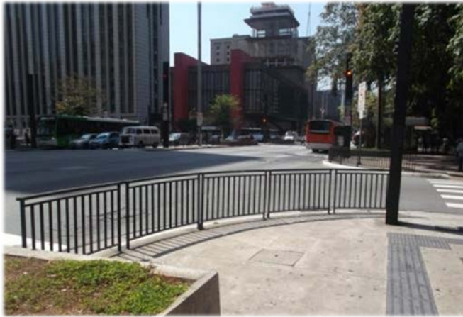
Figura 125 - Conjunto de proteção ao pedestre formado por: gradil, floreira, placas e faixa de pedestres. Fonte: Acervo pessoal, 2012.
