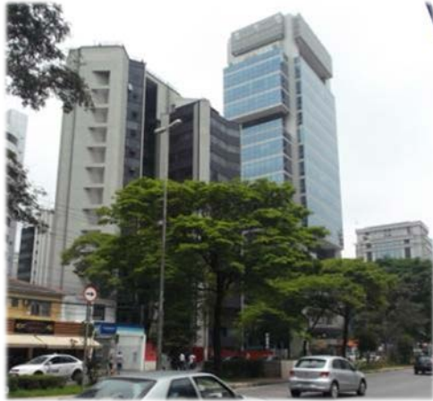
Figura 171 - Edifícios construídos na primeira fase da avenida e os recém-construídos se misturam na paisagem.
