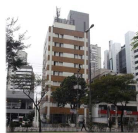
Figura 142 - O único edifício de uso residencial do trecho estudado.
