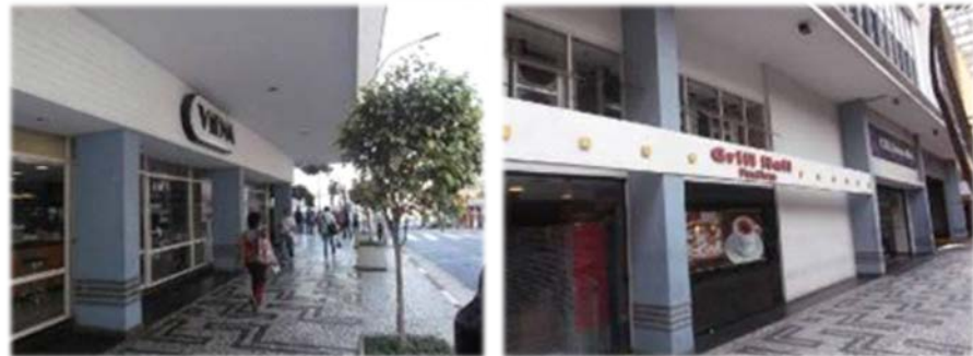
Figura 191 - Restaurantes com acesso pela rua (espaço público) ou pelo interior da galeria. Fonte: Acervo pessoal, 2012.
