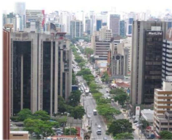
Figura 137 - Vista da Avenida Engenheiro Luís Carlos Berrini.
