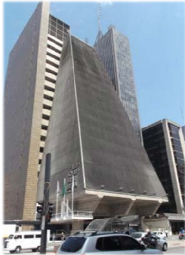
Figura 111 - Edifício da FIESP. Fonte: Acervo pessoal, 2012.
