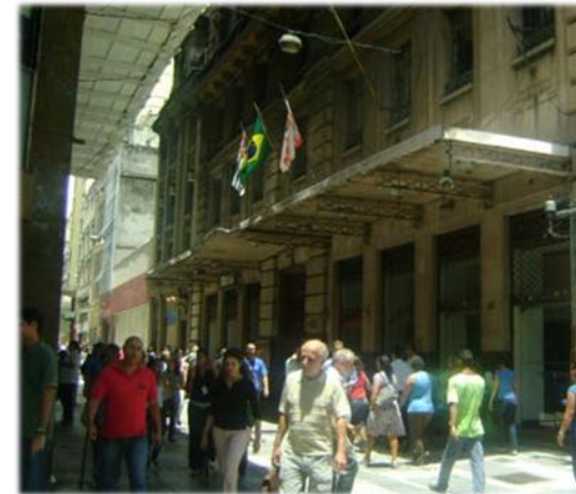
Figura 72 - Marquise do Edifício Martinelli. Fonte: Acervo pessoal, 2012.
