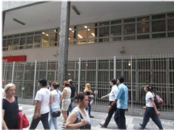
Figura 52 – Exemplo de interface da Rua São Bento que utiliza gradil.
