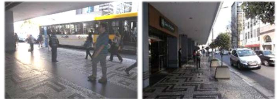
Figura 198 - O revestimento do piso – mosaico português – está presente na calçada e no interior do edifício, separados por granito preto. Fonte: Acervo pessoal, 2012.
