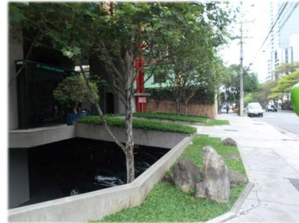
Figura 151 - Exemplo de implantação que não demarca o limite físico entre espaço público e espaço privado.
