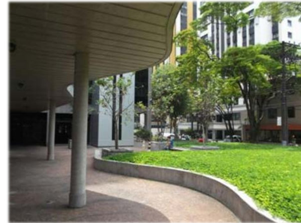
Figura 147 - Espaço de convivência do Edifício Presidente Arthur Bernardes. Fonte: Acervo pessoas, 2012.
