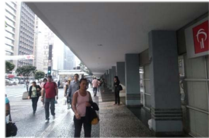
Figura 132 - A marquise do Conjunto Nacional proporciona ao pedestre uma caminhada segura e longe das intempéries. Fonte: Acervo pessoal, 2012.
