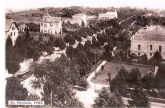
Figura 79 - Vista dos casarões dos barões do café na Avenida Paulista em 1902. Fonte: http://designinnova.blogspot.com.br/2011/12/avenida-paulista-120-anos.html .
