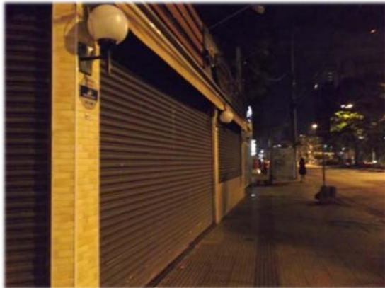
Figura 154 - Estabelecimento comercial da Berrini que utiliza as portas de aço de enrolar.
