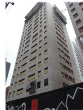
Figura 143 - Empreendimento residencial em construção – Max Haus.
