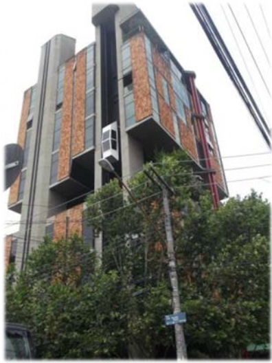
Figura 169 - Sede do escritório do arquiteto Oswaldo Bratke. Fonte: Acervo pessoal, 2012.
