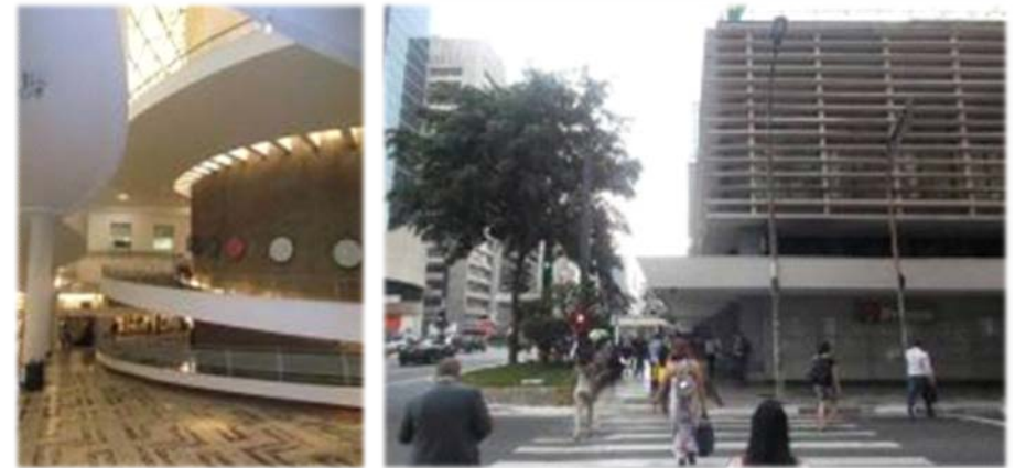
Figura 196 - Arquitetura diferenciada no interior do Conjunto Nacional e os brises da fachada.
