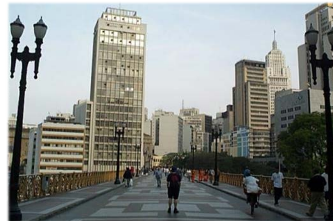
Figura 60 - Viaduto Santa Ifigênia. Fonte: Acervo pessoal, 2012.
