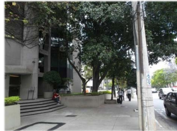
Figura 173 – Exemplo de edifício rotacionado na Berrini, ou seja, sua fachada não é alinhada com a rua.
