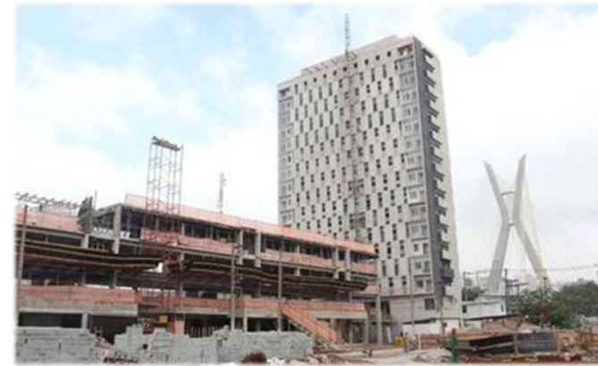
Figura 164 - Residencial Jardim Edith em fase de construção (foto tirada em junho de 2012).
