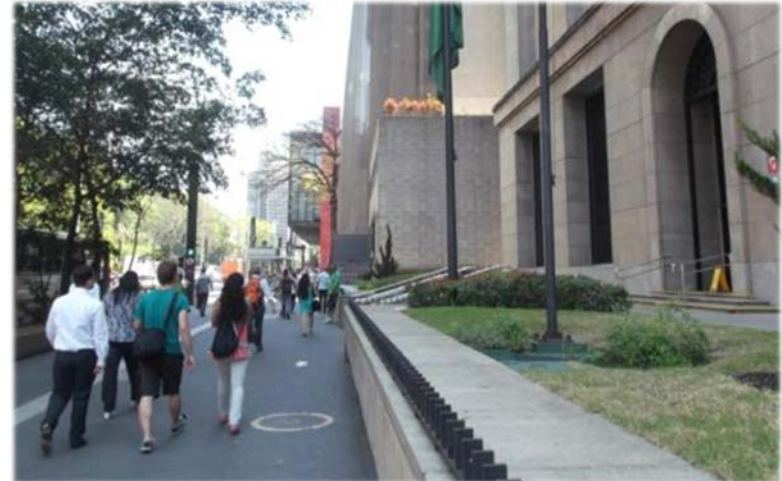
Figura 108 - Edifício do Banco Bradesco – exemplo de fachada com muro baixo.
